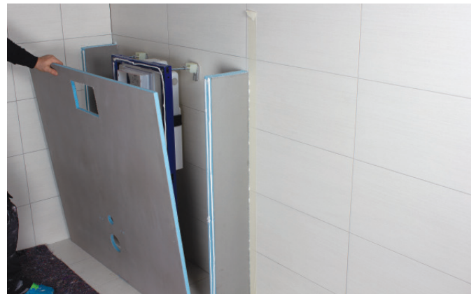
Påfør monteringslim på ramme, vegg og gulv.
