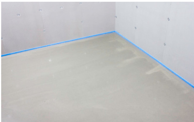
Ferdig avrettet gulv.
