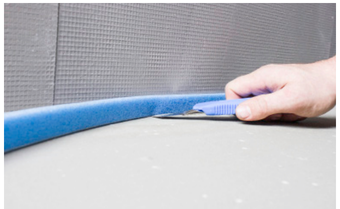
Overskytende ekspansjonsbånd fjernes.
