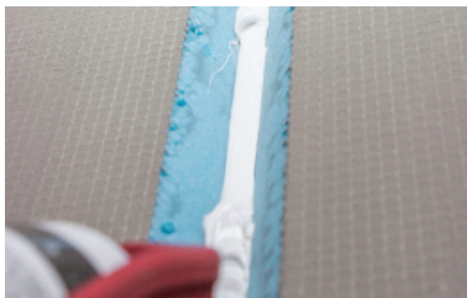
Påfør lim i rørkassens v-spor.
