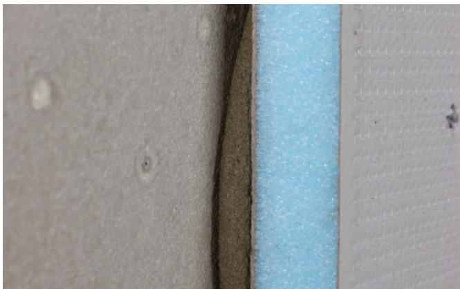
Fest platen på vegg og kontroller innretning.
