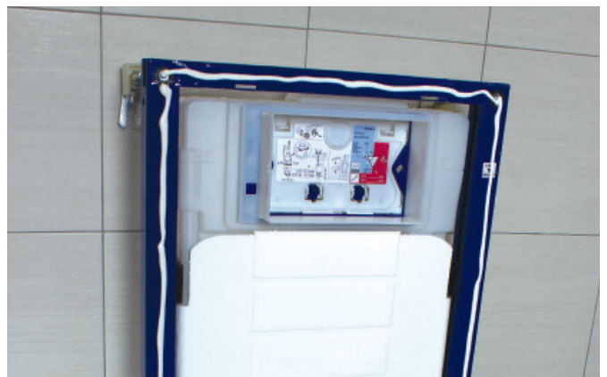
Påfør monteringslim på ramme, vegg og gulv.
