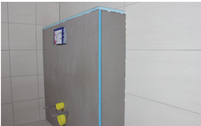
Lag dreksåpning og forsterkning.
