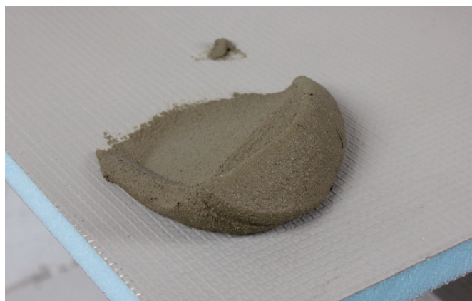
Legg på tilstrekkelig med lim.
