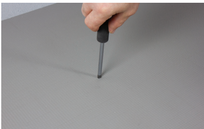
Lag hull til senter av limpunktene.
