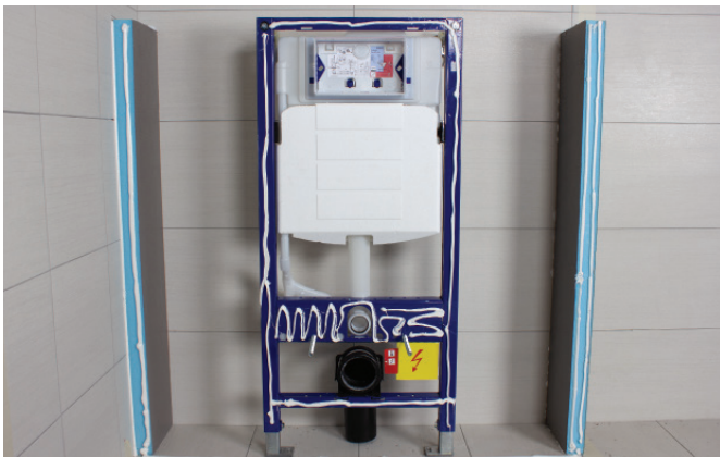
Ta mål og tilpass kassen
